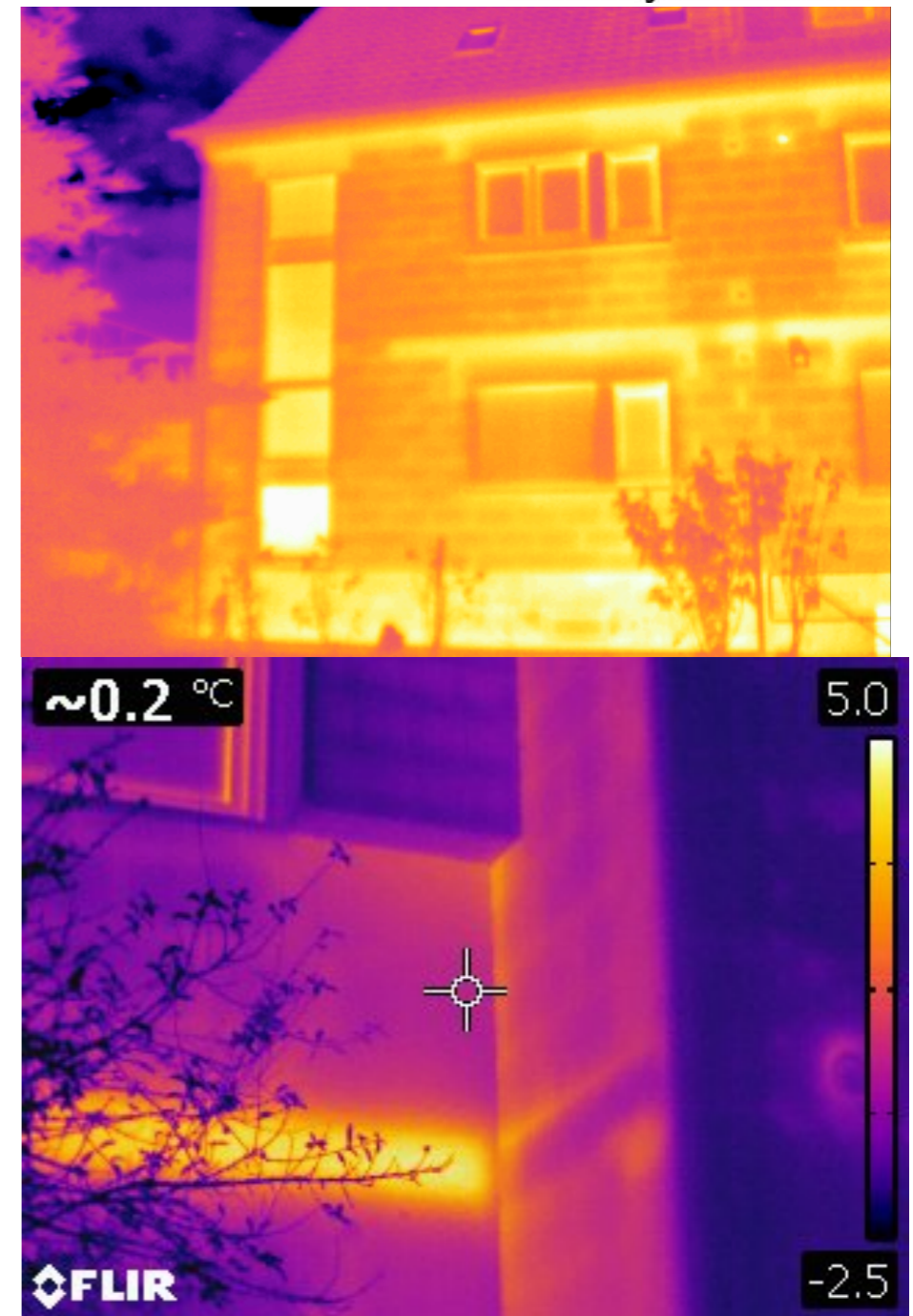
Thermografieaufnahmen haben keinen Bezug zum Beispielhaus und zeigen Schwachstellen anderer Häuser. Quelle: InDiGuD
